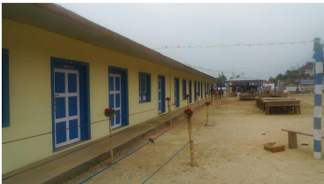
Edificio a valle di quattro aule
