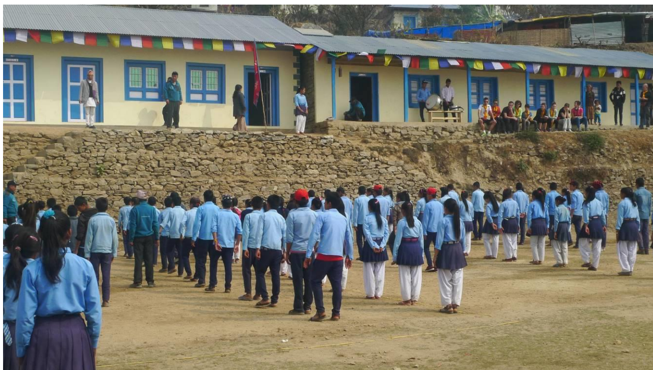
Parte dell'edificio a monte di quattro aule ed edificio a monte con due aule
