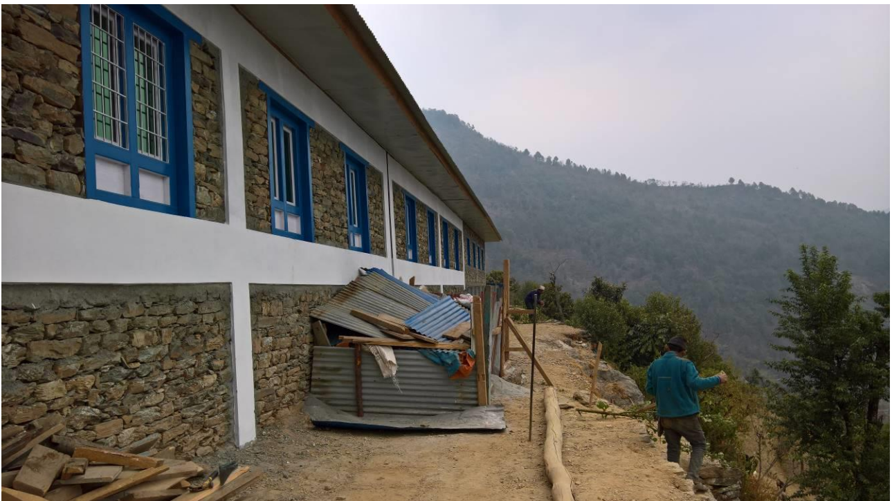
Retro dell'edificio a valle di quattro aule
